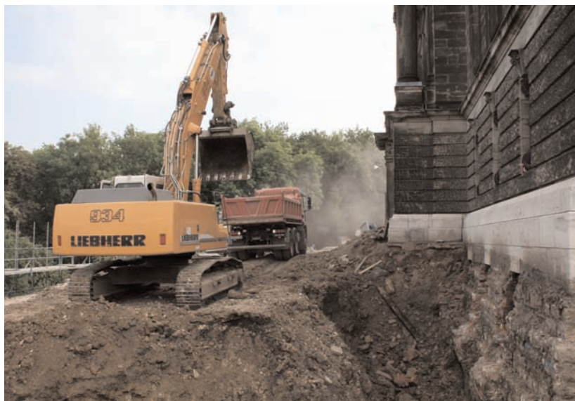
Freilegung der Fundamente, Juni 2010
